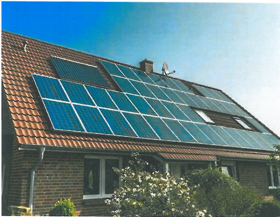
Épületre telepített napelerőmű és napkollektor.
