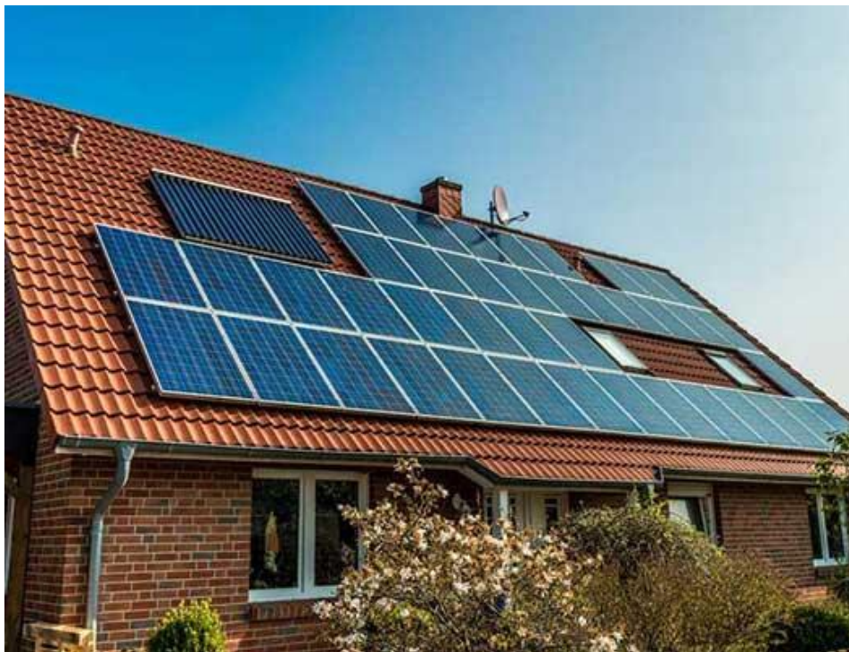
Épületre telepített napelem és napkollektor.
